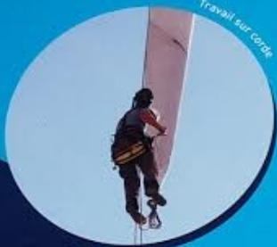
Inspection du rotor
